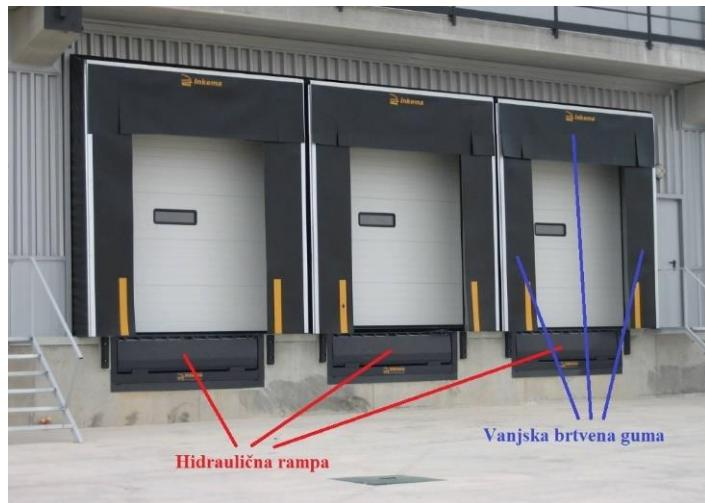
**Slika 38. Hidraulična rampa i vanjska brtvena guma**
