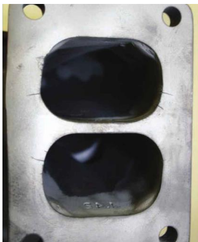
Slika 30. Pukotine na kućištu turbine uslijed visokih temperatura [15]
