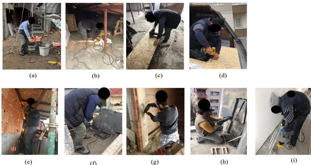
Slika 24. a) Priprema žbuke b) Rezanje metala c) Rezanje kalupa d) Krovopokrivanje e) Zavarivanje f) rušenje betona g) Bušenje-1 h) Bušenje-2 i) Vodoinstalaterstvo [13]
