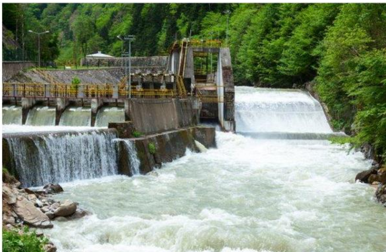
Slika 4.2 Primjer protočne HE
