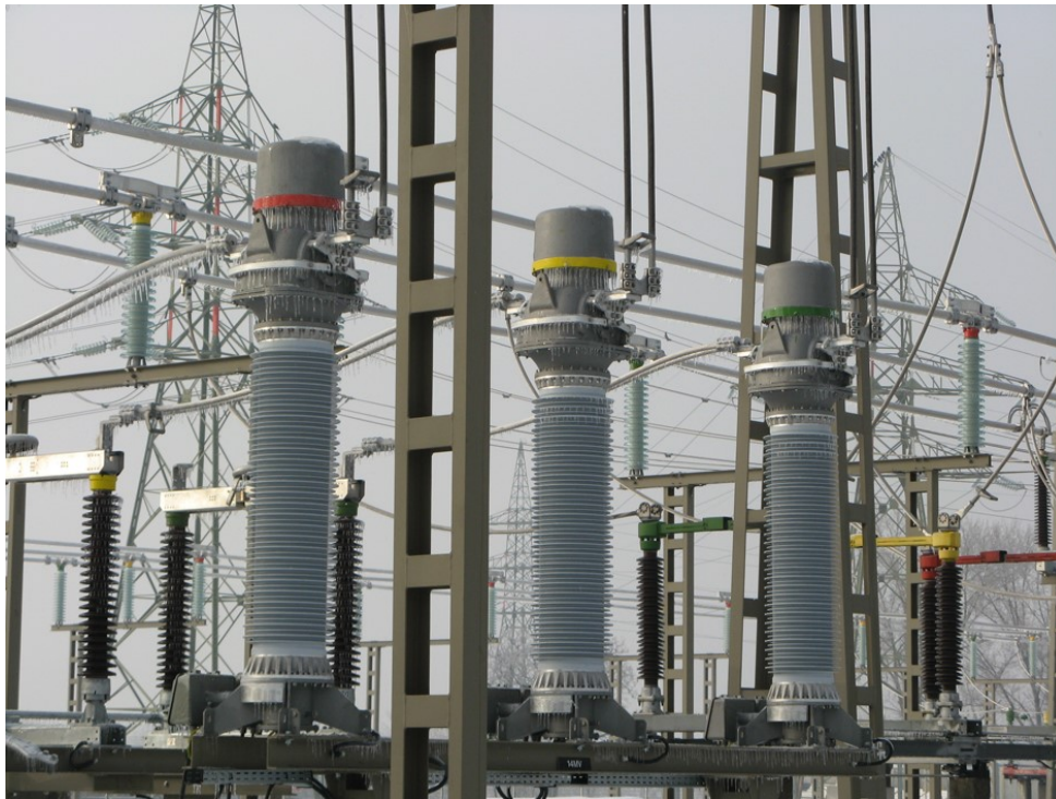
Slika 11. Mjerni transformator tipa VAU [7]
