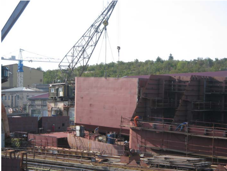
Slika 42 Montaža bloka tanka tereta br. 1 na navozu
