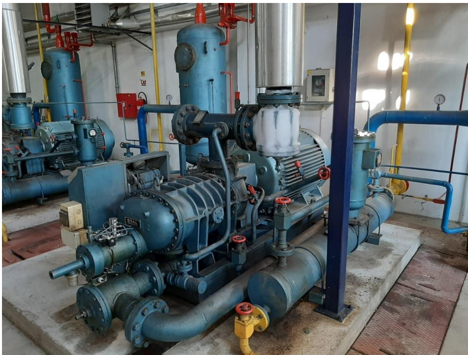
Slika 4 Vijčani kompresor direktnog rashladnog sustava
