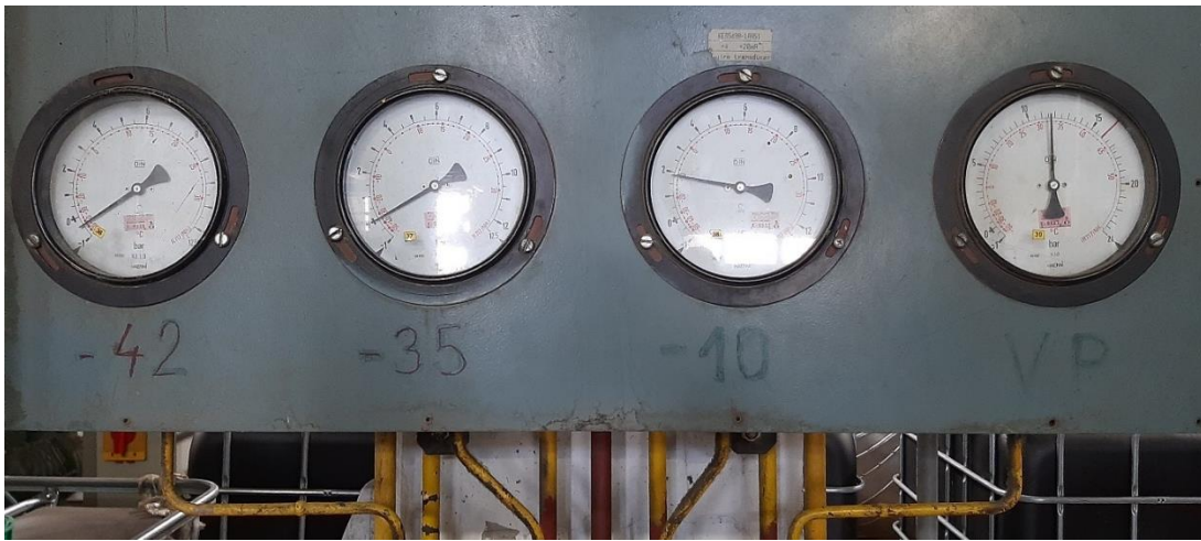
Slika 8 Analogni manometri različitih temperaturnih razina direktnog sustava hlađenja
