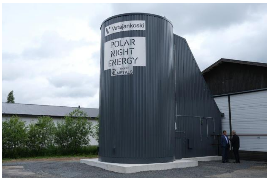
Slika 6 Visokotemperaturni toplinski spremnik punjen pijeskom [8]
