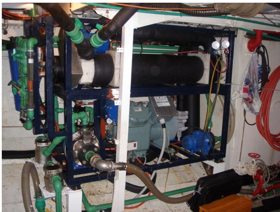
Slika 35. Kavezna izvedba sustava za proizvodnju leda montirana u strojarnicu broda [21]
