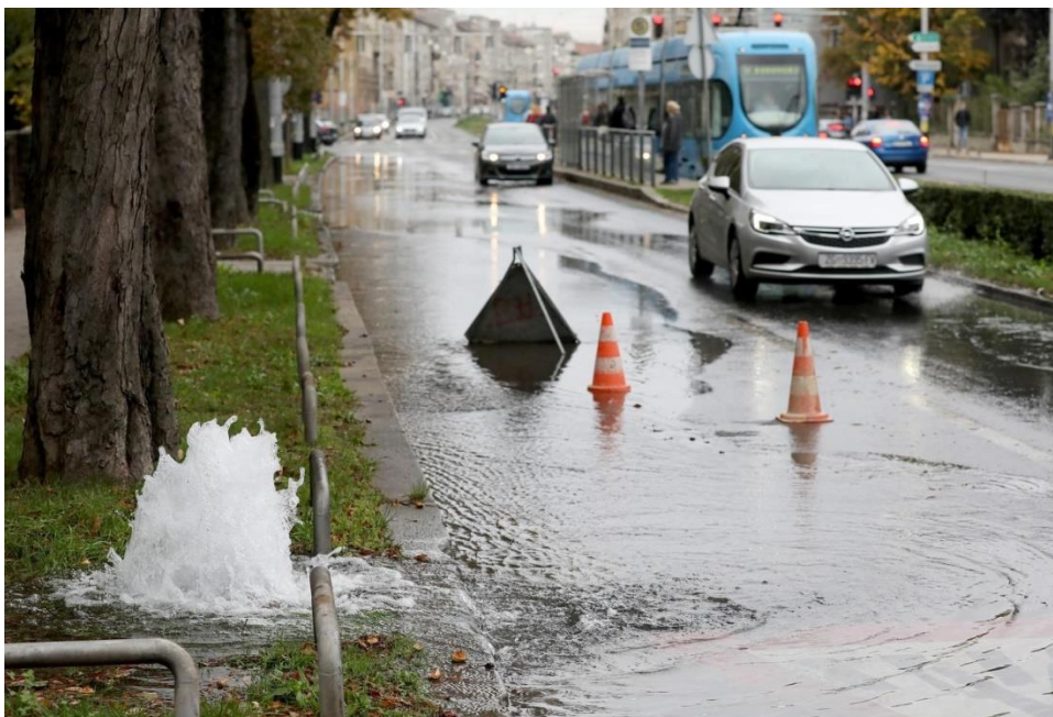
Slika 2. Posljedice puknuća cjevovoda [6]
