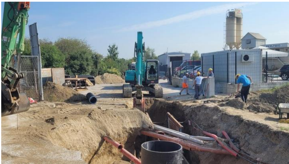
Slika 16. Radovi na izgradnji javnog kanala sanitarne i oborinske odvodnje [35]
