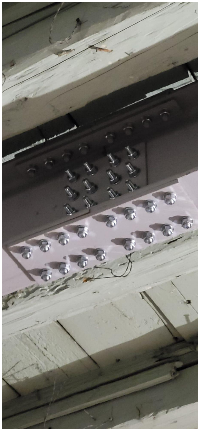
Slika 81 : Prikaz spoja između IPE i IPE profila
