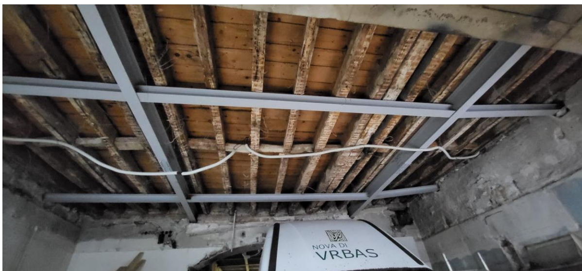
Slika 78 : Prikaz gotove konstrukcije
