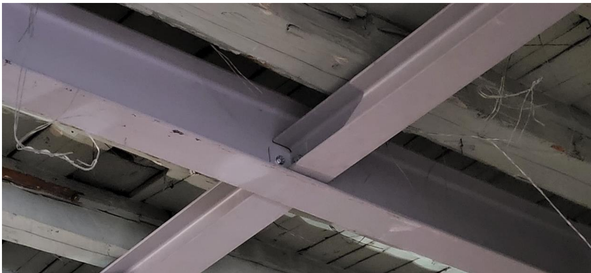
Slika 80 : Prikaz spoja između IPE i HEA profil
