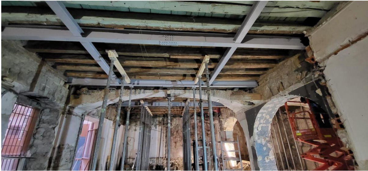
Slika 79 : Prikaz gotove konstrukcije
