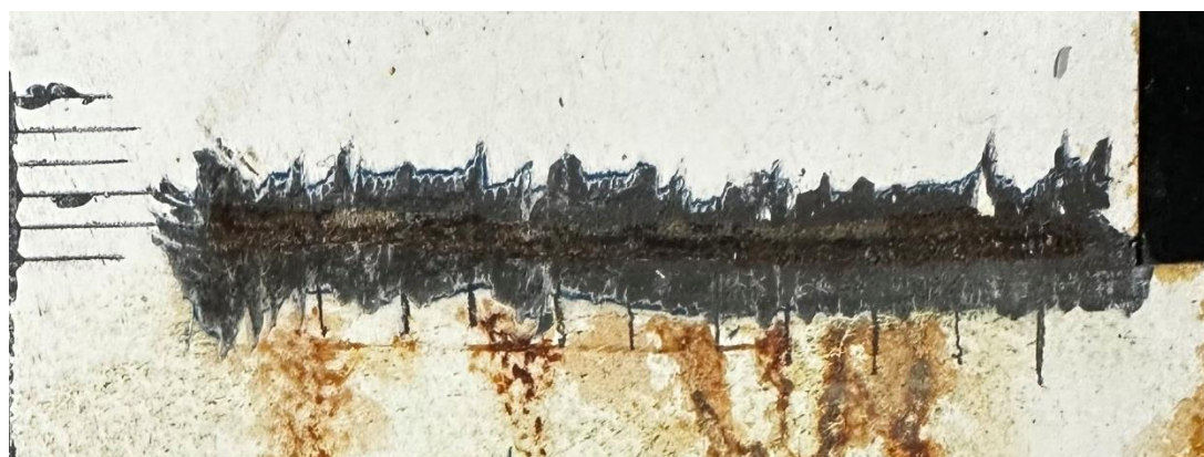
Slika 39. Postupak ocjenjivanja stupnja korozije oko ureza
