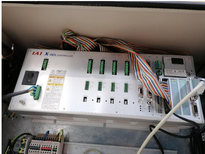
Slika 2.1.1 – Kontroler pokreta IAI X-SEL Controller
