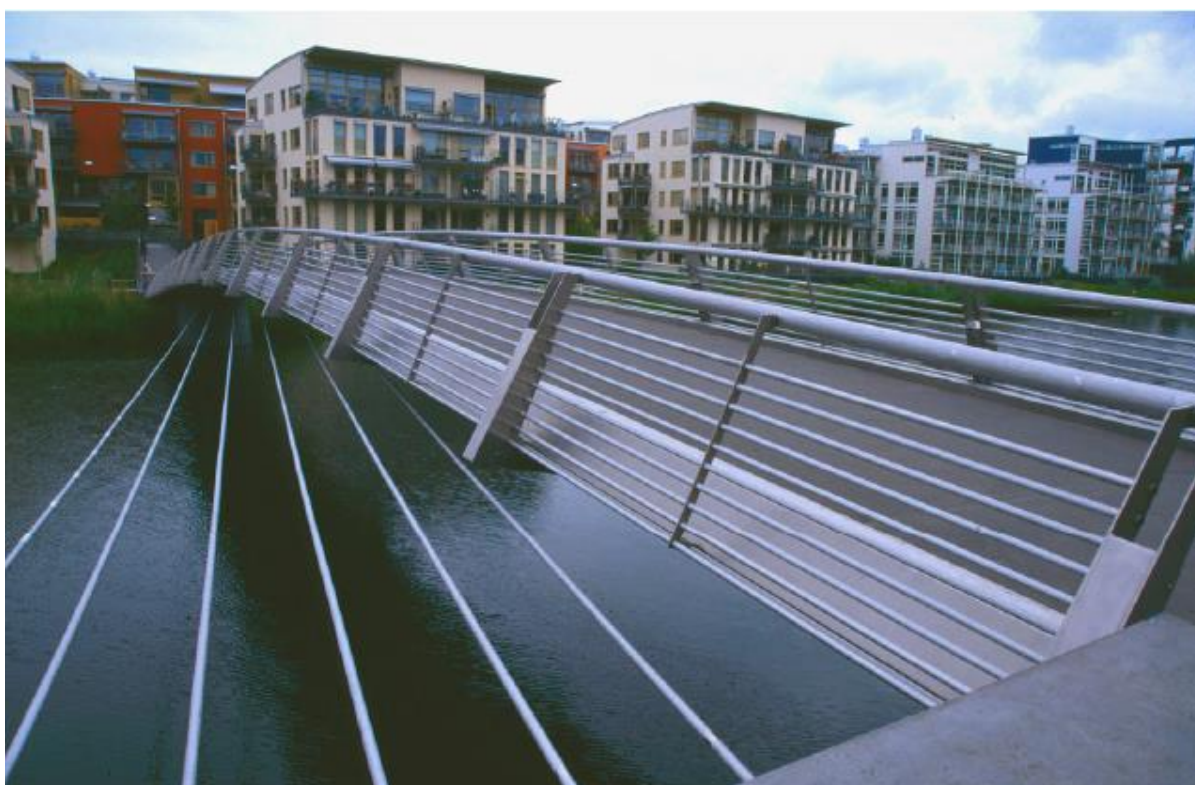
Slika 8. Apace most u Švedskoj izgrađen od 2205 dupleks čelika [16]
