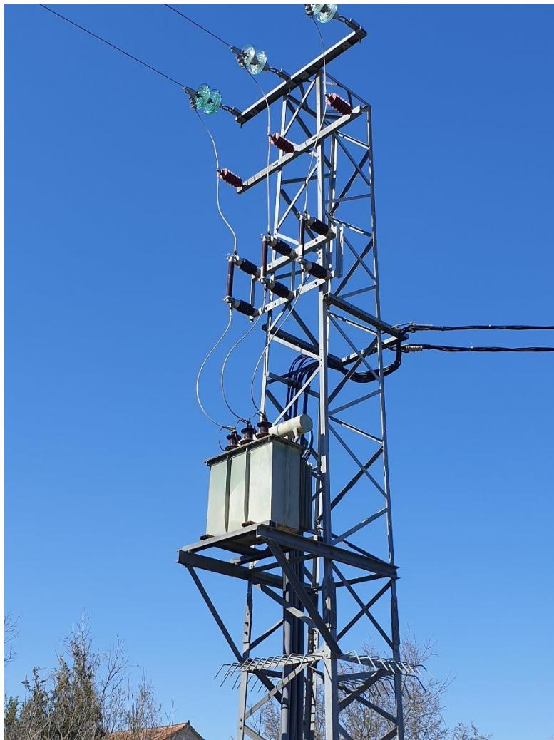
**Slika 7: Fotografija distributivnog transformatora**
