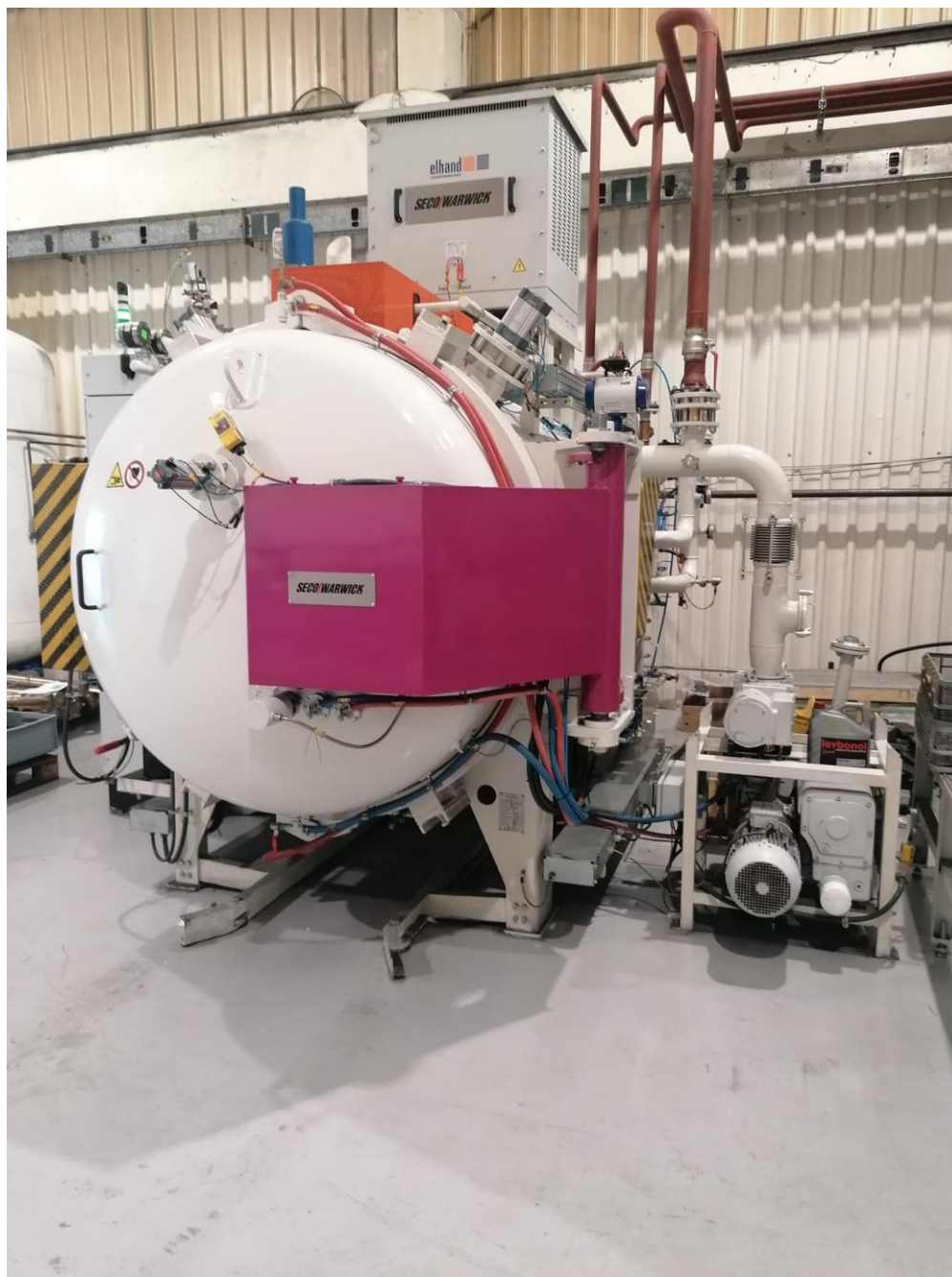
Slika 25. Vakuumska peć u Centru toplinske obrade d.o.o.
