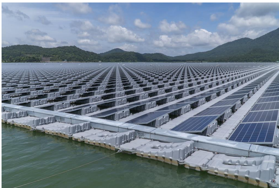
Slika 10. Pontonska konstrukcija sustava FPV [40]
