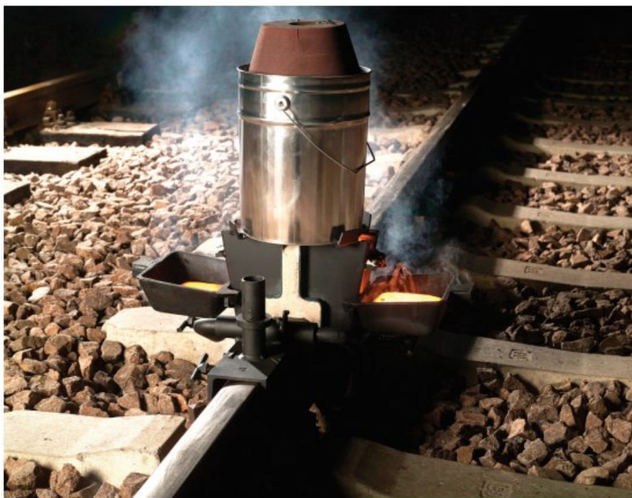
Slika 2. Prikaz aluminotermijskog postupka zavarivanja tračnica [11]
