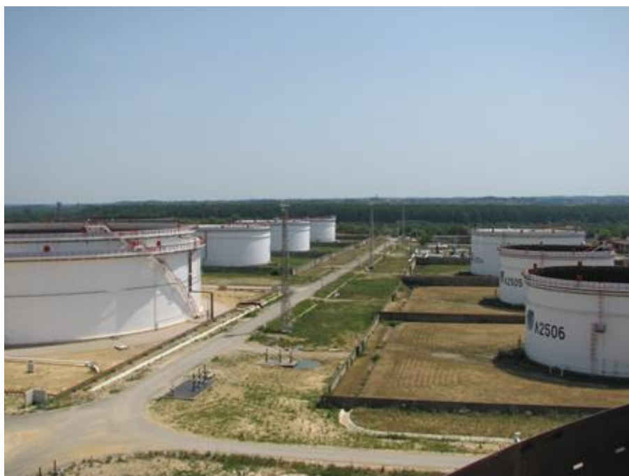
Slika 6. Prikaz spremnika zaštićenih premazima, Terminal Sisak
