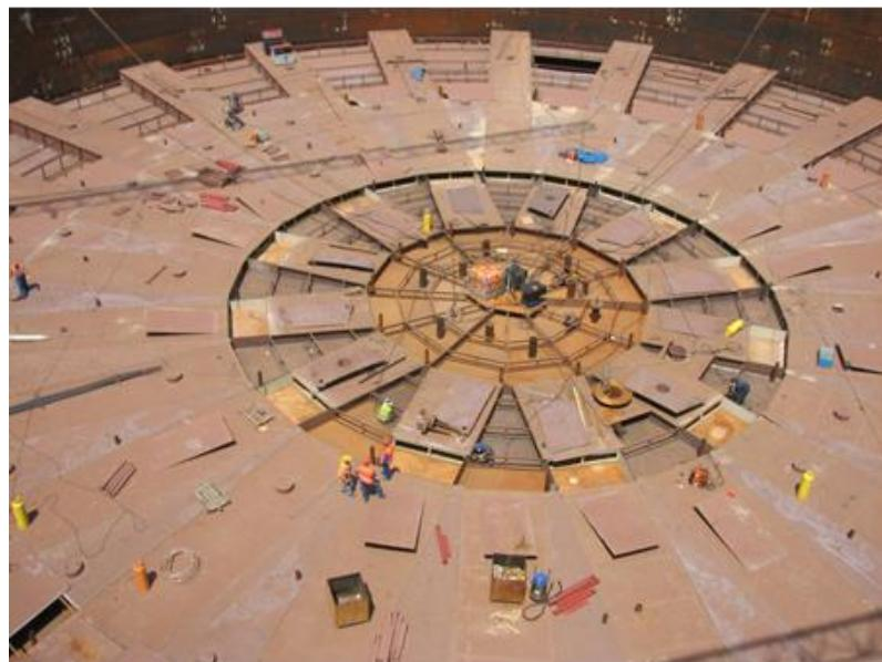
**Slika 1. Plutajući krov, Terminal Sisak**
