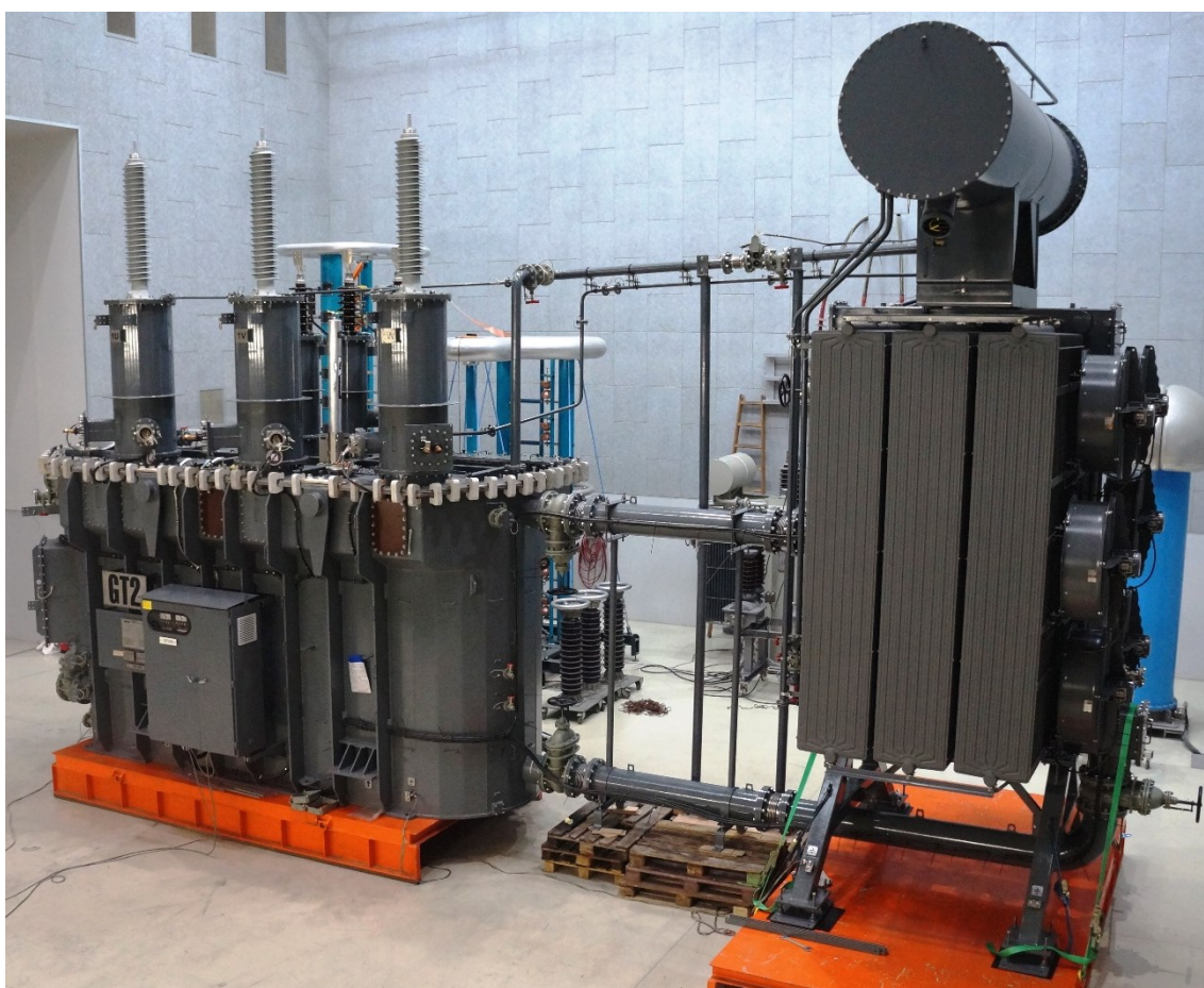
Slika 2.5 Odvojeni sustav za hlađenje transformatora 1 [5]
