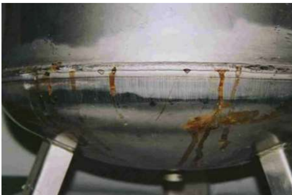
Slika 28. Korozija u procijepu preklopnog zavarenog spoja [18].
