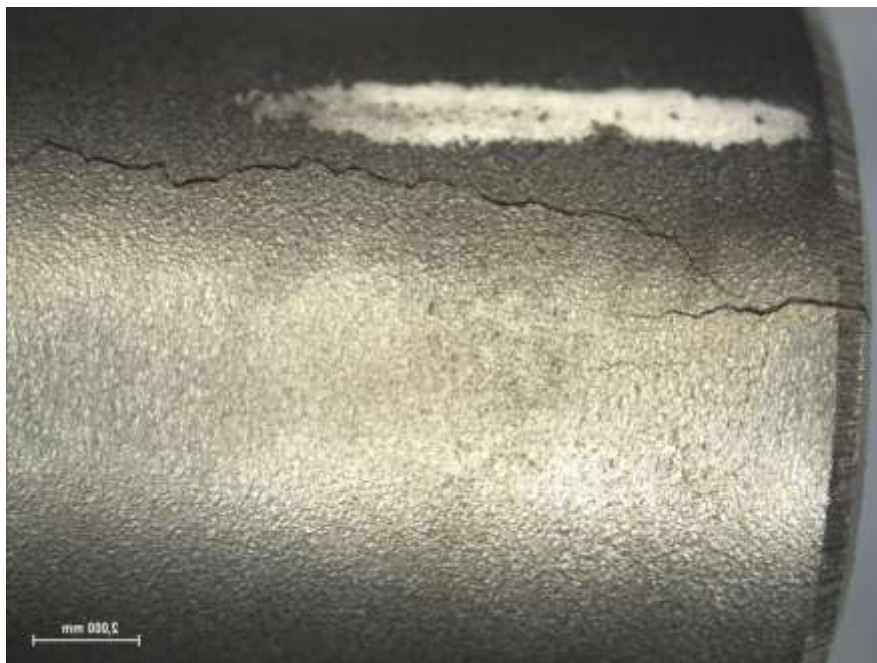
Slika 97. Pukotina na vanjskoj površini luka uzorka od čelika EN 1.4362 (AISI 2304).
