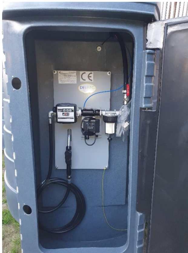
Slika 4. Oprema spremnika za gorivo
