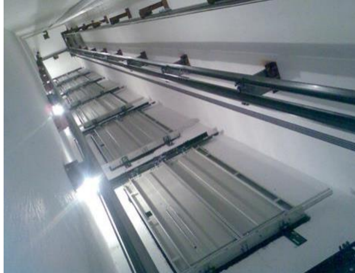
Slika 28. Vozno okno čvrste konstrukcije [3]
