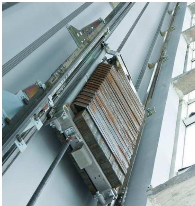
Slika 26. Protuuteg
