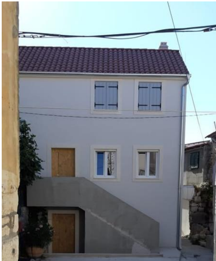
Slika 5. Zapadna fasada kuće
