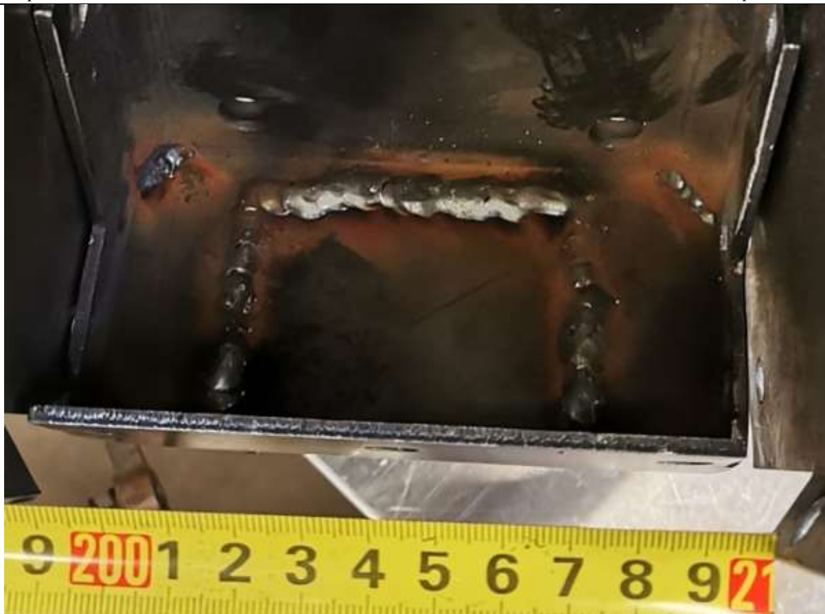
Slika 27 Zavareni spoj izveden u proizvodnom pogonu TEP-a
