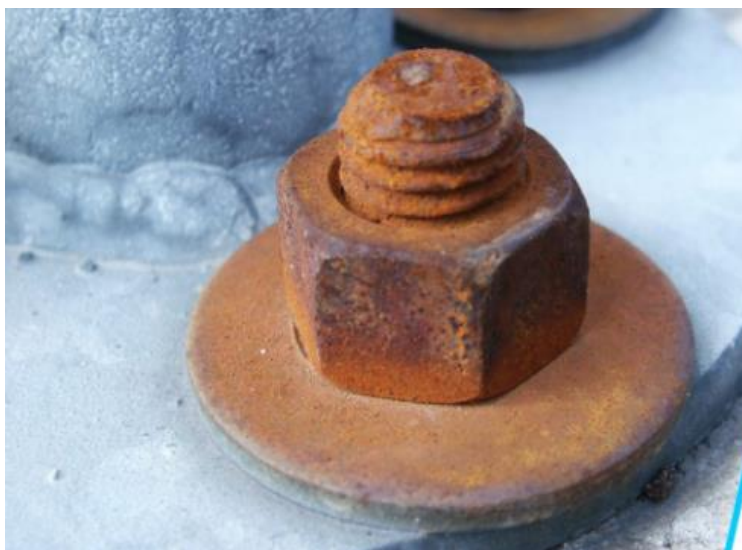
Slika 17. Primjer galvanske korozije [22]
