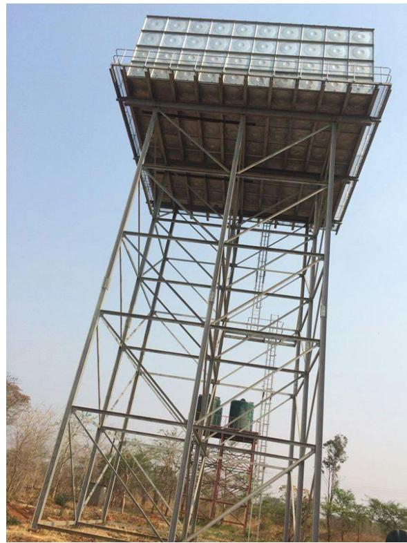
Slika 3. Spremnik za vodu napravljen od konstrukcijskog čelika [11]
