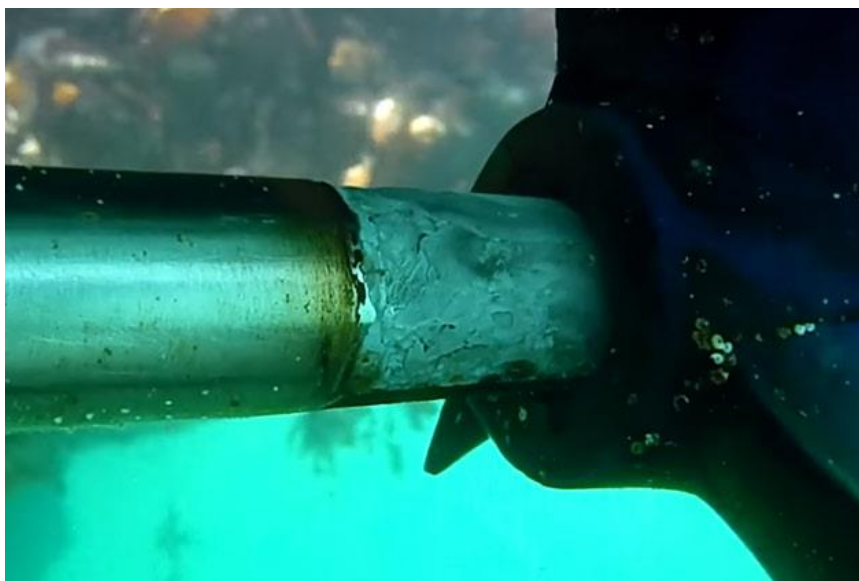
Slika 20. Korozija aluminija u procijepu [24]
