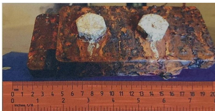
Slika 2. Galvanska korozija između vijka i ploče [7]
