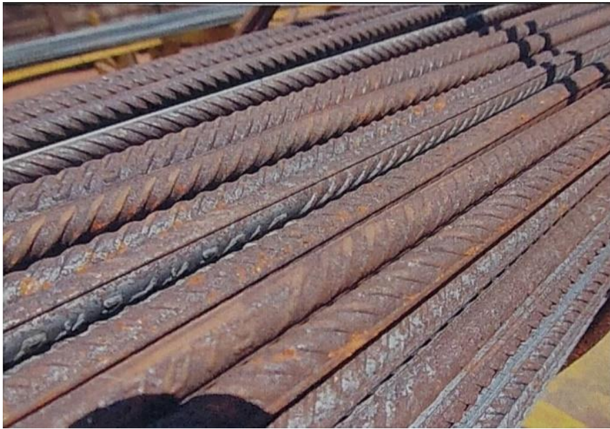
Slika 13. Atmosferska korozija nelegiranog čelika [7]
