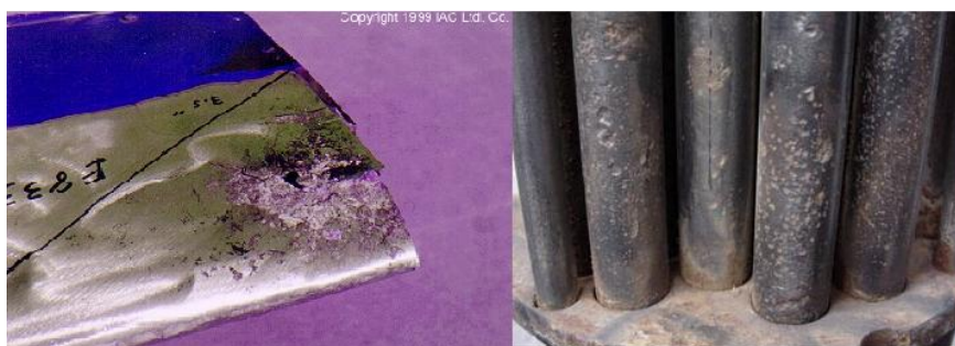
Slike 30: Primjeri gubitka materijala uslijed korozije [2]
