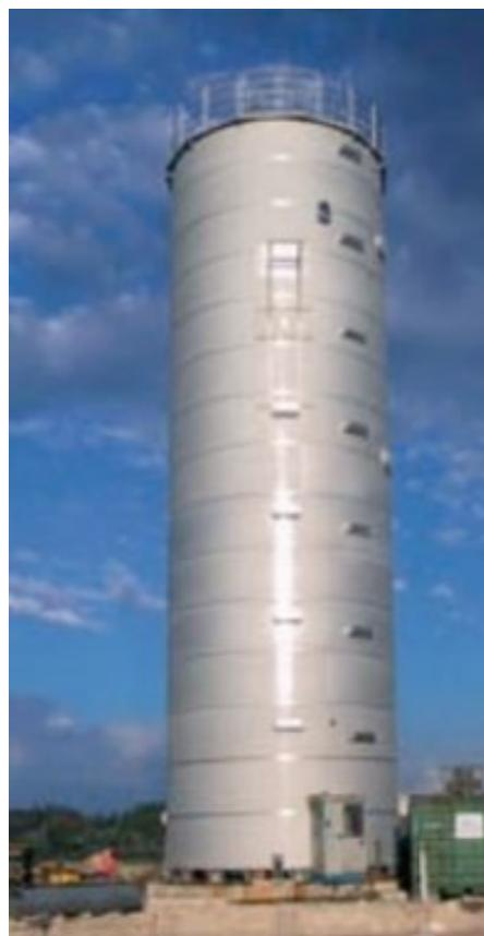
Slika 15. Spremnik za etanol od dupleks nehrđajućeg čelika [18]
