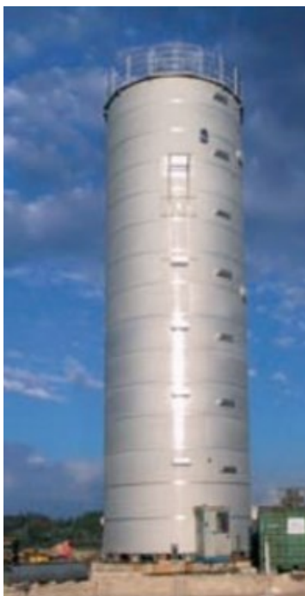
Slika 15. Spremnik za etanol od dupleks nehrđajućeg čelika [18]
