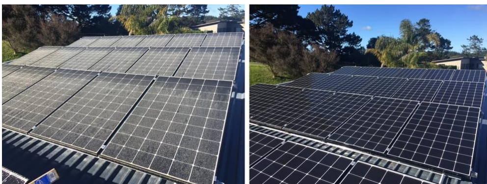
Slika 1.6. Prljave i očišćene solarne ploče [20]
