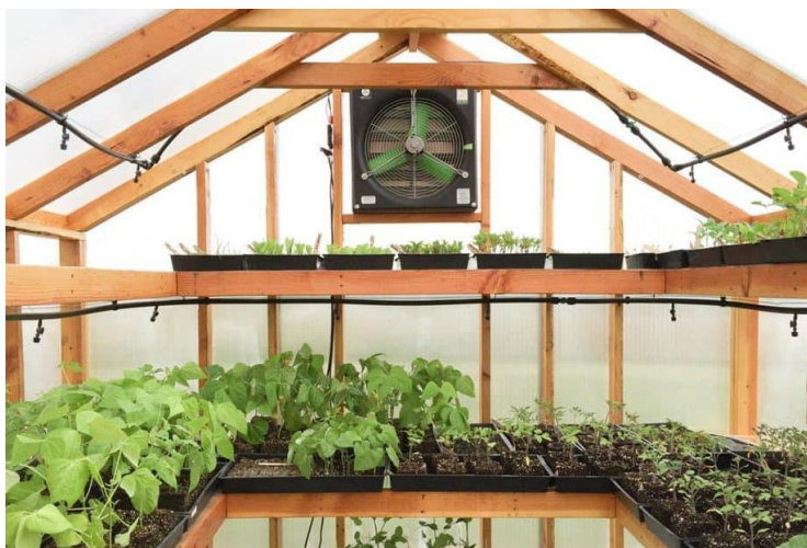
Slika 2.11. Hlađenje pomoću ventilatora [19]
