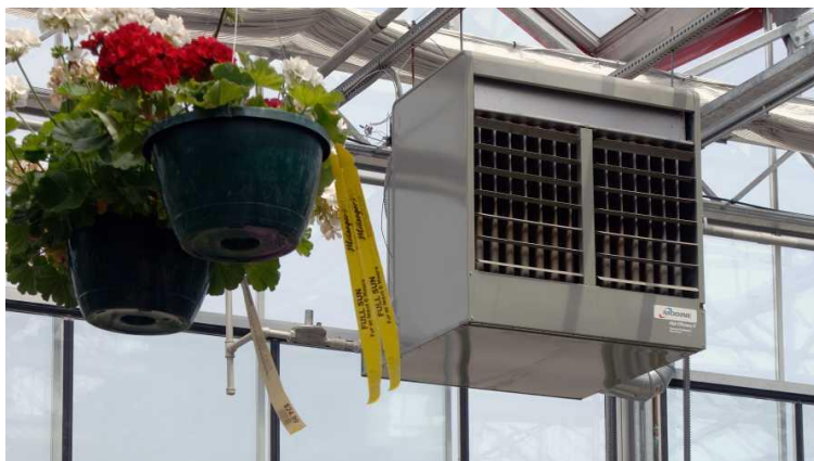
Slika 2.12. Grijanje pomoću električne grijalice [20]
