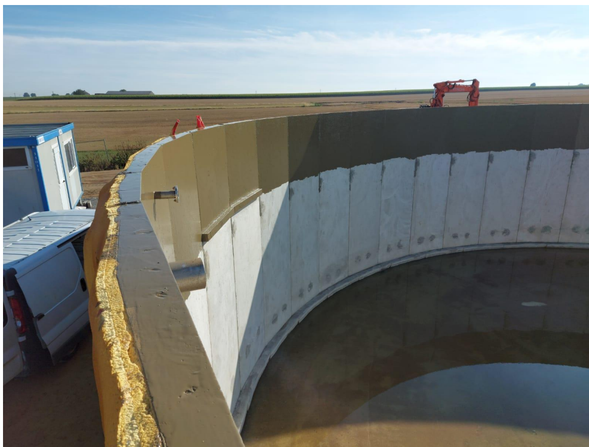
Slika 25. Nanošenje epoksidnog premaza na unutarnju stijenku digestora [29]
