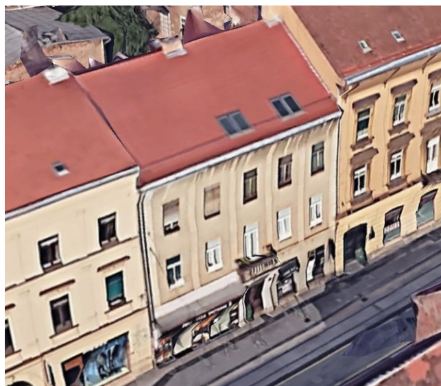
Slika 17. Karakteristična zgrada Bloka 19 u prostoru [35]
