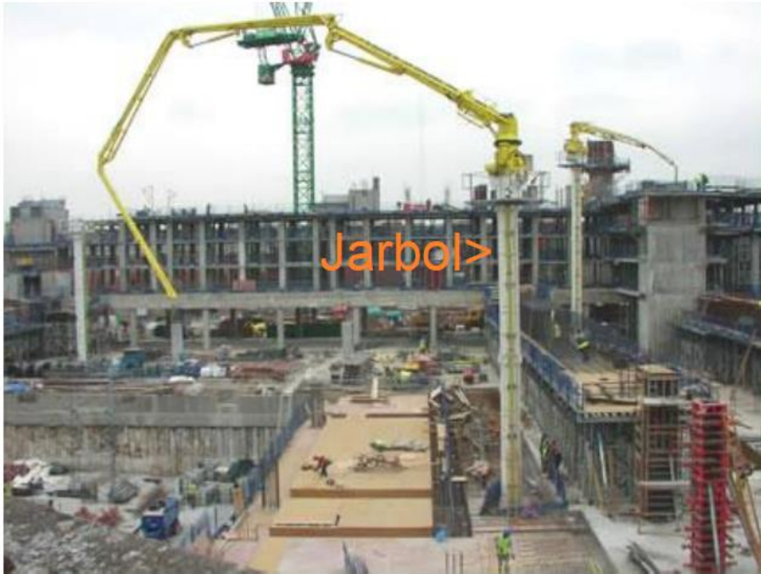
Slika 3. Cijevni jarbol za transport betona [8]
