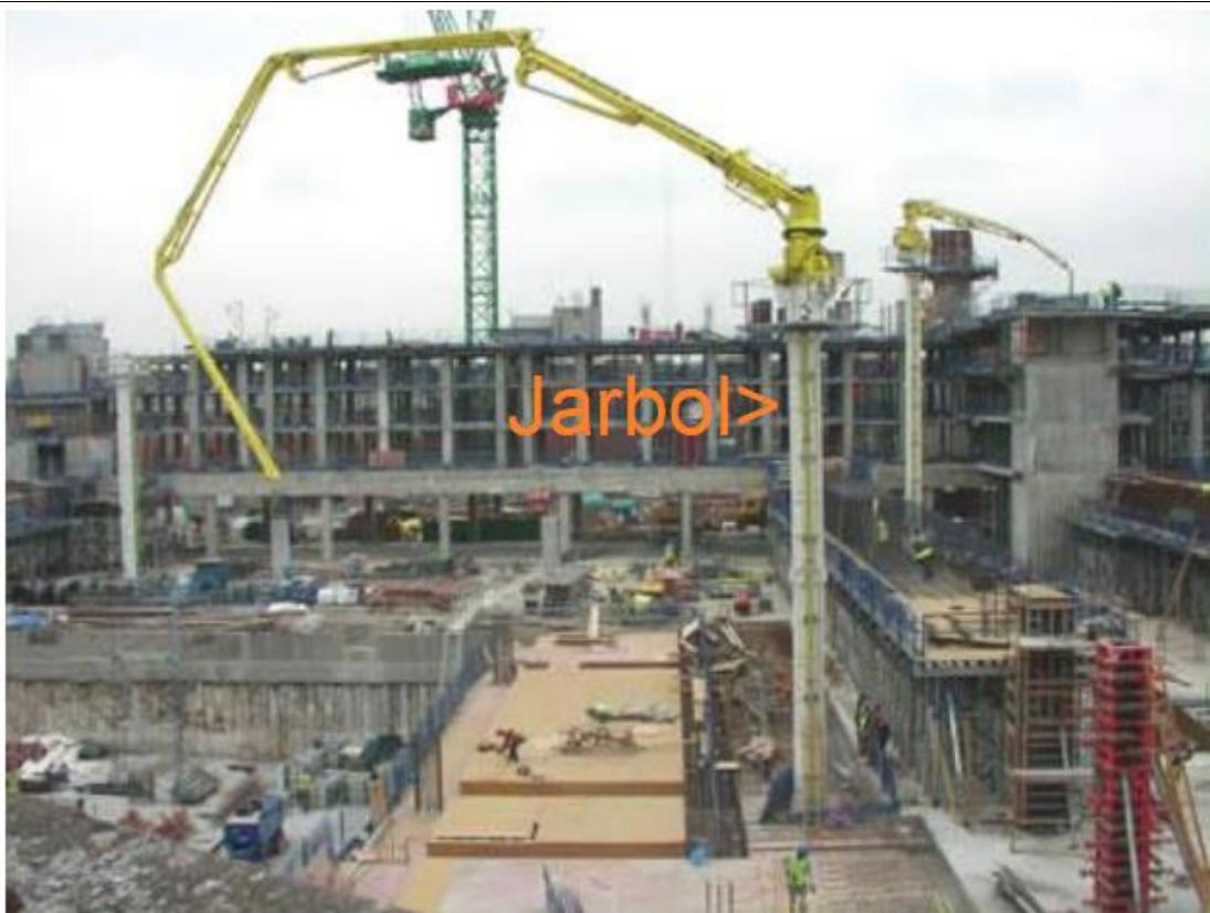
Slika 3. Cijevni jarbol za transport betona [8]
