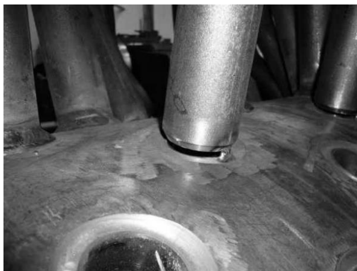
Slika 45. Brizgalica s komorom u proizvodnji parnih kotlova [14]
