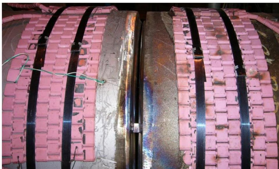
Slika 34. Elektrootporno predgrijavanje cijevi čelika P91 [18]
