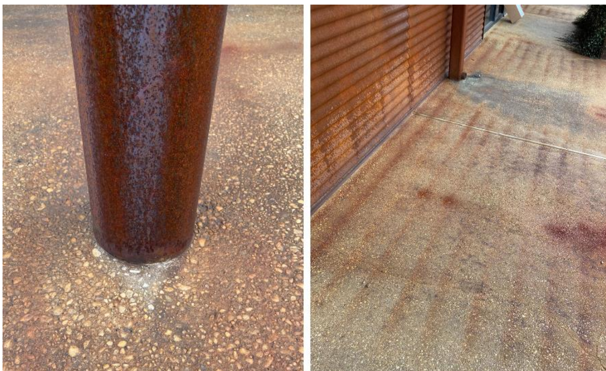
Slika 11. Posljedice ljuštenja oksidnog sloja Corten čelika [26]
