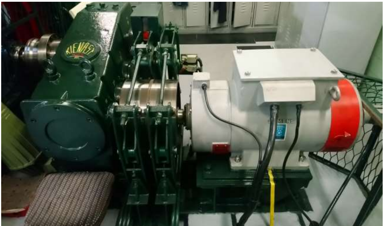
Slika 21 Elektromotor i reduktor za pogon uspinjače - slika sa servisa 25.10.2021.
