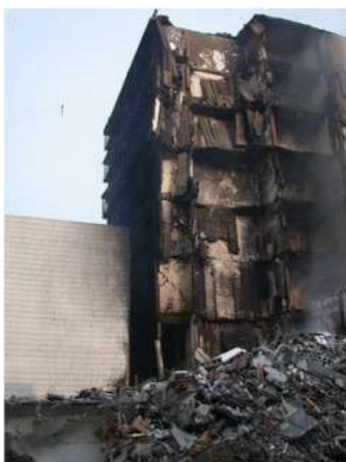
(a) Sjeverno pročelje
