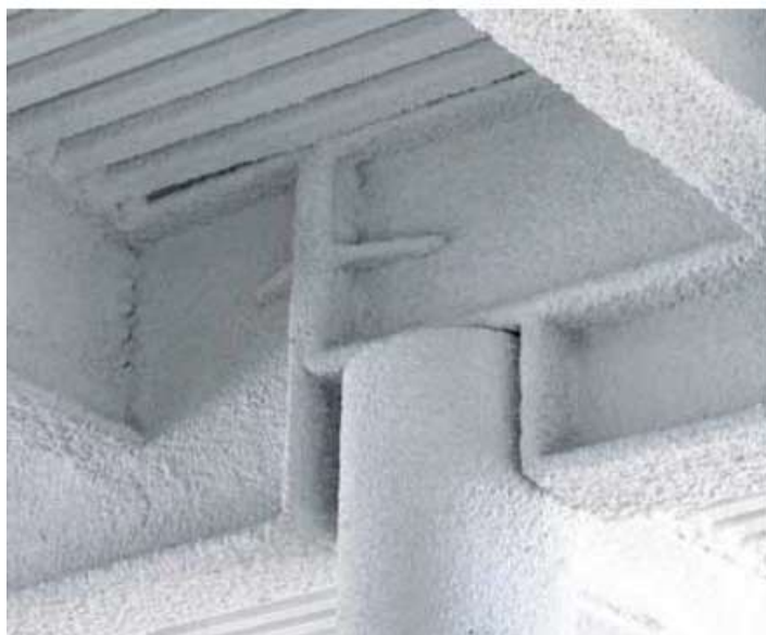
Slika 9. Protupožarna zaštita cementnim sustavom [19]
