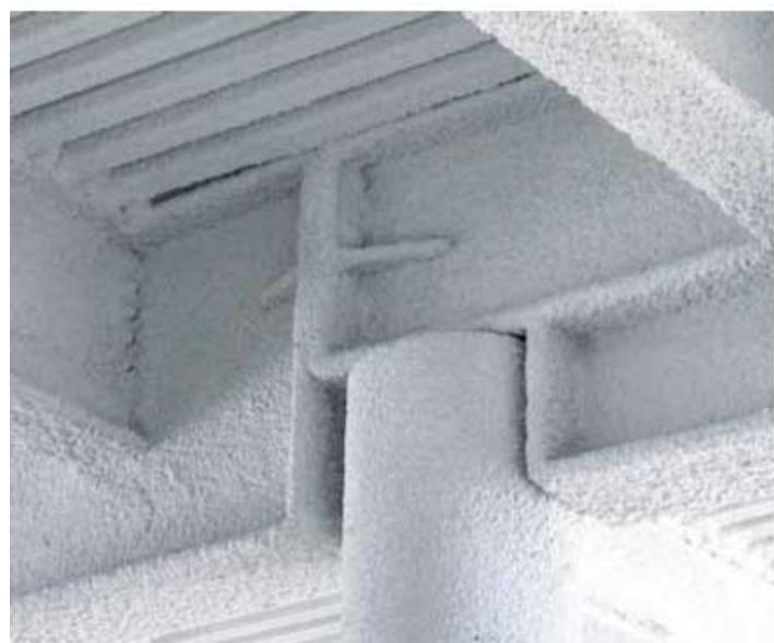
**Slika 9. Protupožarna zaštita cementnim sustavom [19]**
