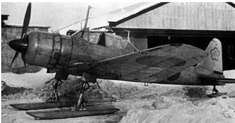
Slika 5. Podvozje izvedeno kao skije [6]
