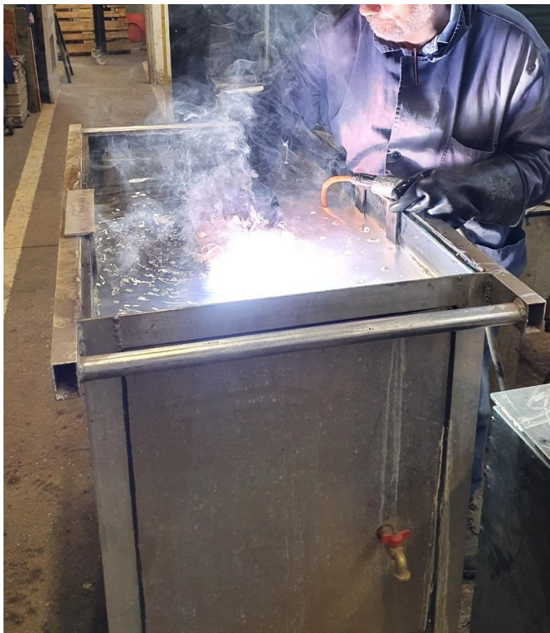
Slika 41. Provođenje zavarivanja pod vodom
