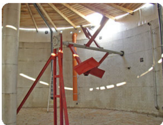
Slika 2.27. Miješalica s horizontalnom osovinom
