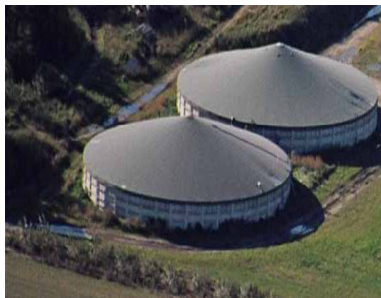
Slika 2.37. Spremišta digestata prekrivena membranom
