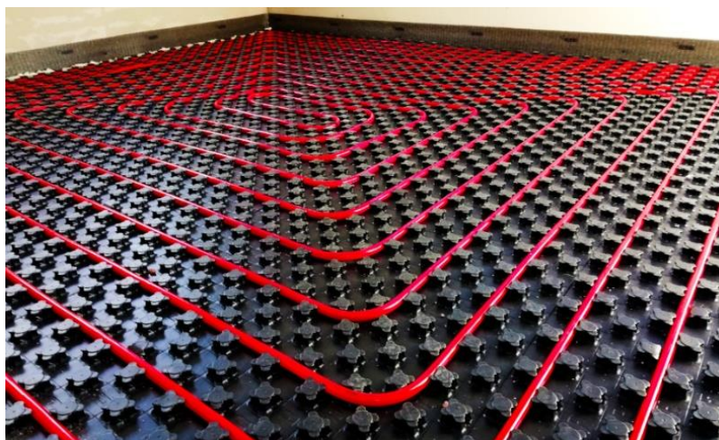
Slika 3.4. Ugradnja serpentske petlje na rešetkastu podlogu [9]
