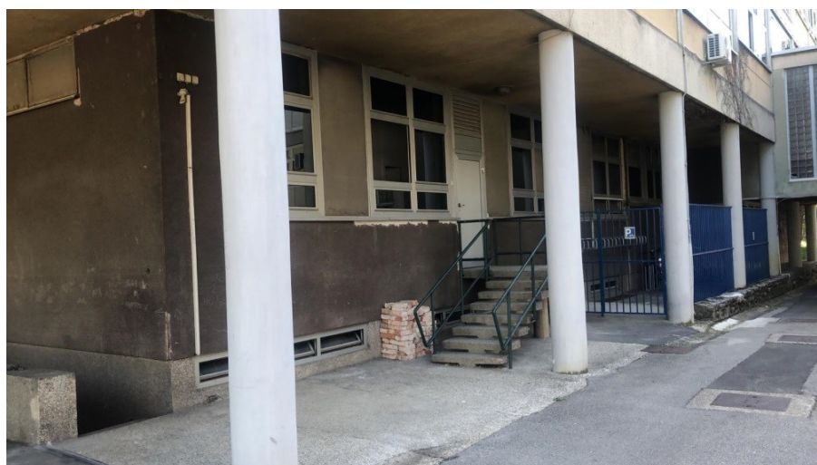
Slika 12. Postojeće stanje sjevero-istočnog pročelja niskog prizemlja
