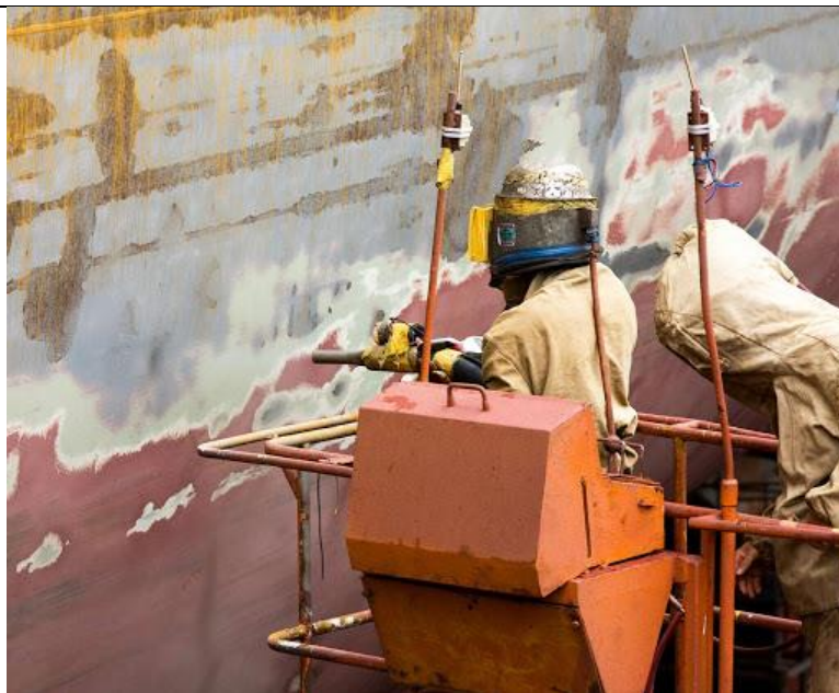
Slika 3. Ručno sačmarenje u brodograđevnoj industriji[12]
