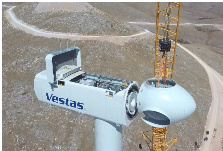
**Slika 2.6.** Montaža glave rotora na gondolu [8]
