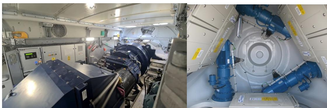
**Slika 2.7.** Unutrašnjost gondole (lijevo) [9] i glave rotora (desno) [10]
