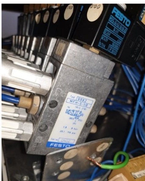
Slika 7. Blok MFH-5-1/8 ventila
