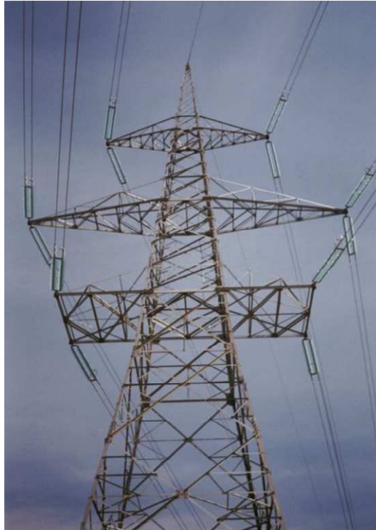
Slika 4-2-1: Glava 400 kV-nog stupa dalekovoda (arhiva Instituta za elektroprivredu i energetiku d.d, Zagreb)
